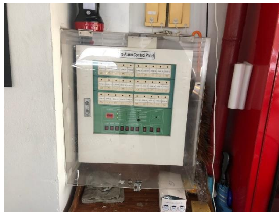
รูปที่ 19 แผงควบคุม (Fire Alarm Control Panel : FCP)
