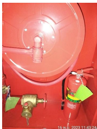
รูปที่ 22 ตู้เก็บสายฉีดน้ำดับเพลิงพร้อมอุปกรณ์
